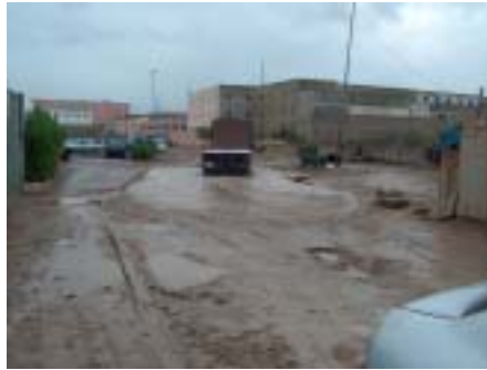
Amélioration des infrastructures de la Z.I
